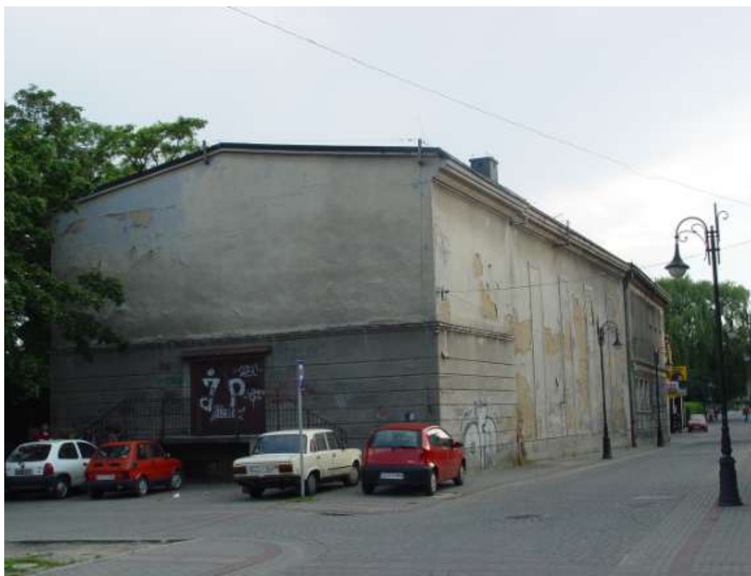
Kino „Na Starówce” – stan istniejący, widok od ul. Bramkowej
