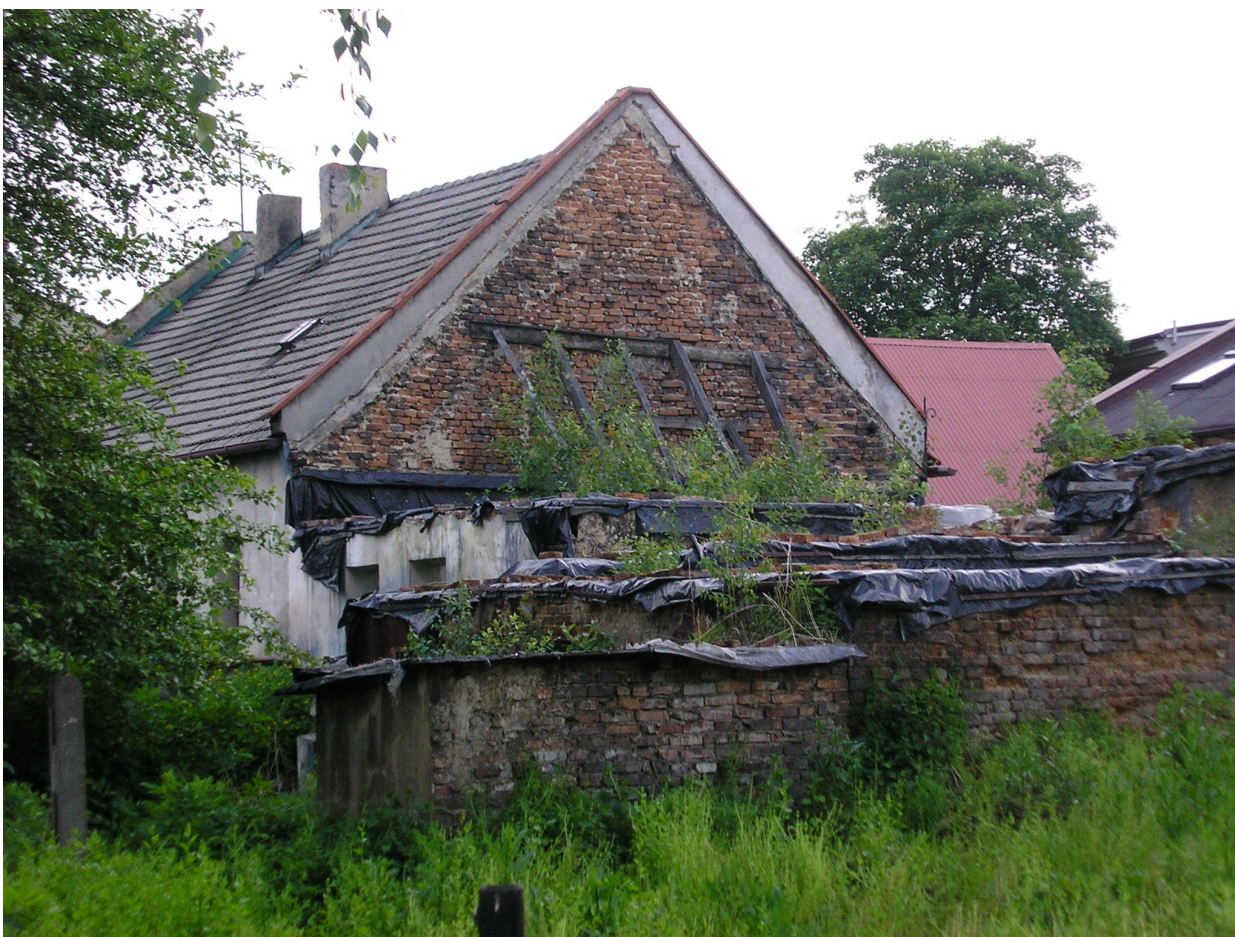
Rysunek 5 Przypory zabezpieczające ścianę szczytową
