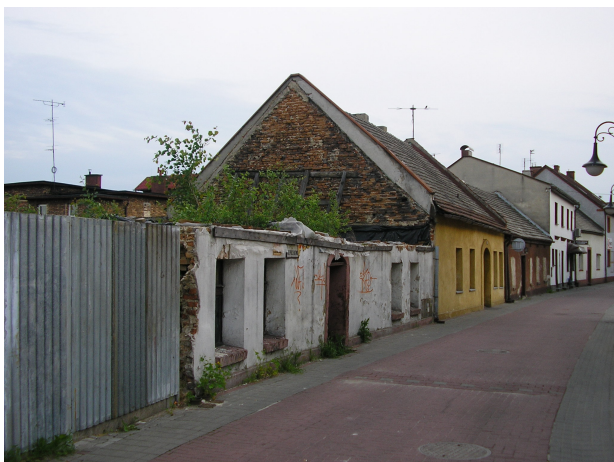
Rysunek 1 Widok na elewację frontową budynków numer 33 i 35
