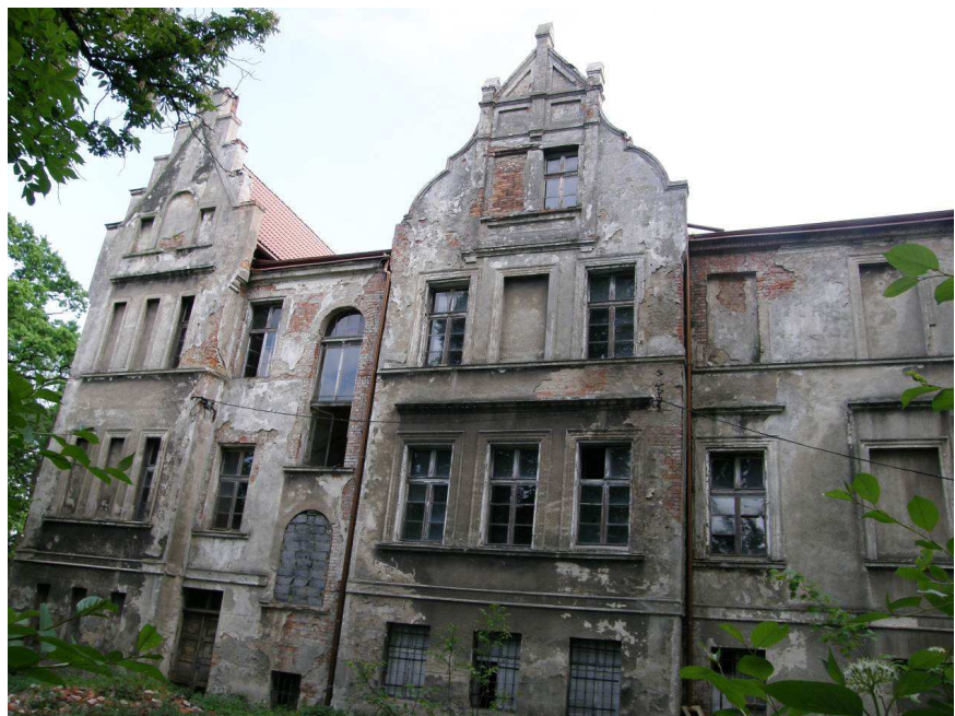
PAŁAC W BARANOWICACH ELEWACJA PÓŁNOCNA BUDYNKU / STAN Z 2011R./
