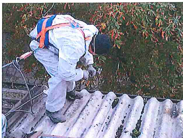
Fot. 3. Usuwanie materiałów zawierających azbest
