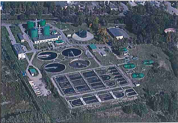
Fot. 5. Oczyszczalnia ścieków w Gliwicach
