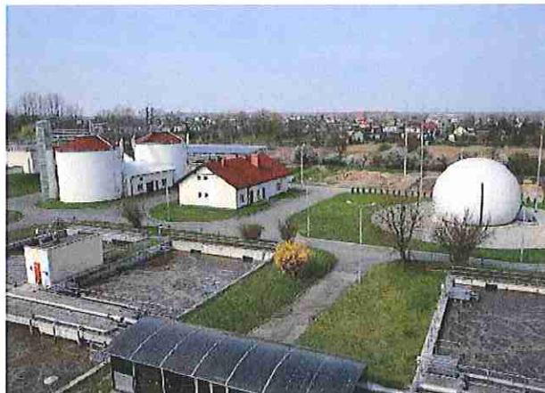
Fot. 8. OŚ Żory część osadowa ze zbiornikiem biogazu
