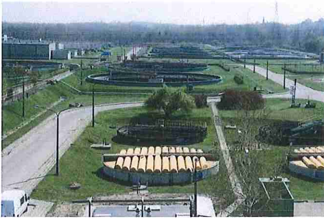
Fot. 7. Oczyszczalnia ścieków Radocha II w Sosnowcu
