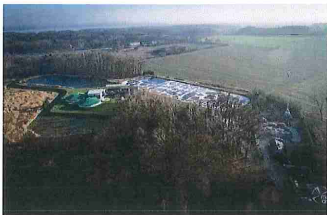
Fot. 15. Widok oczyszczalni w Świerklańcu po modernizacji
