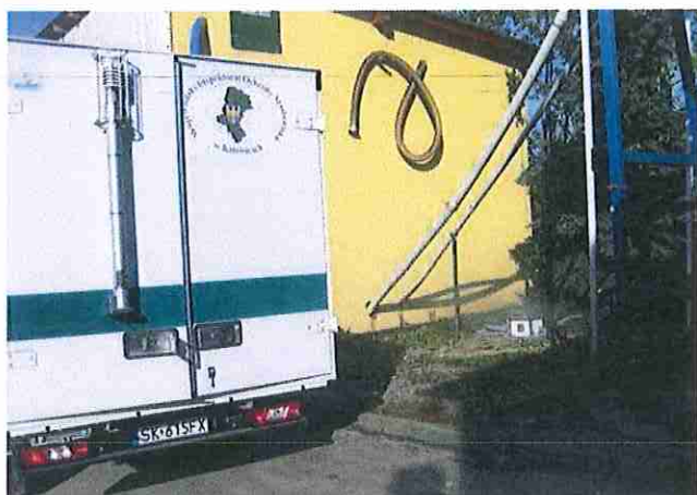
Fot. 1. Sprawdzenie szczelności osadnika wybieralnego z użyciem generatora dymu - lokalizatora przyłączy kanalizacyjnych
