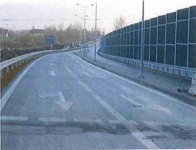
Fot. 1. Budowa północnej obwodnicy miasta Pszczyna
