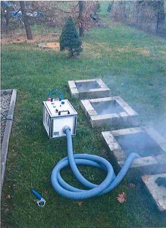
Fot. 3. Sprawdzenie szczelności osadnika wybieralnego z użyciem generatora dymu - lokalizatora przyłączy kanalizacyjnych
