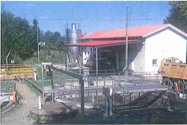
Fot. 11. Stacja higienizacji osadu Oś Foch III w Knurowie
