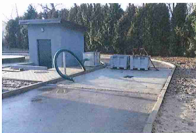
Fot. 16. Pompownia ścieków surowych oczyszczalni w Świerklańcu po modernizacji
