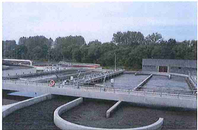
Fot. 10. Oczyszczalnia ścieków Jaworzno Dąb nowy reaktor biologiczny
