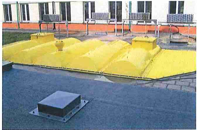
Fot. 8. Oczyszczalnia ścieków Radocha II w Sosnowcu, kanał między budynkiem krat a pompownią główną
