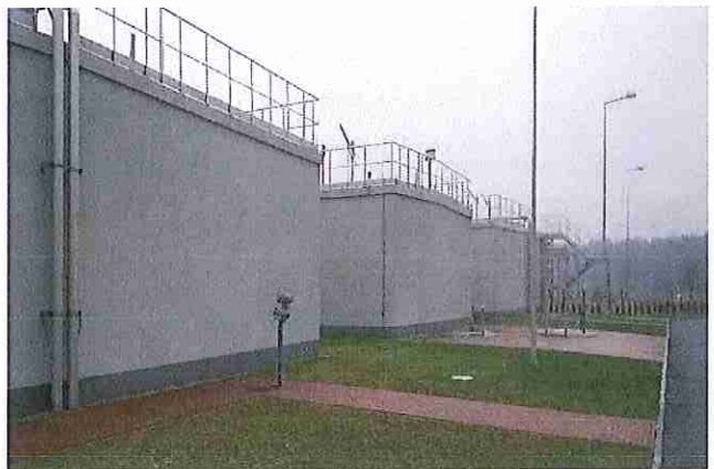
Fot. 14. Sekwencyjny reaktor biologiczny wraz ze zbiornikiem retencyjnym oczyszczalni w Ożarówicach
