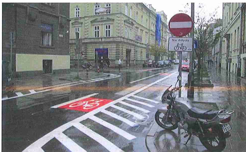
↑ Kontrapas wyznaczony oznakowaniem pionowym i poziomym.
