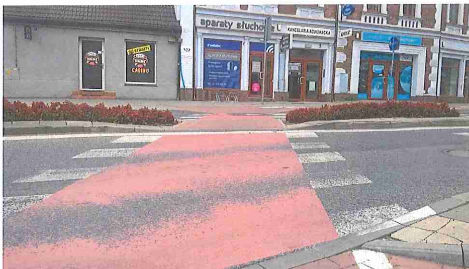
↑ Zbyt wysokie krawężniki utrudniają bezpieczną ewakuację rowerzysty, ul. Dolne Przedmieście.
