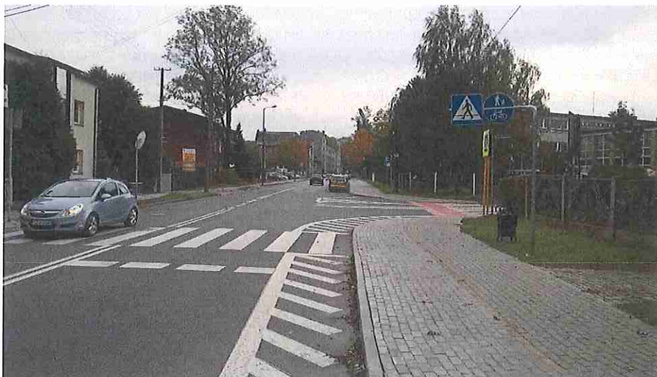
↑ Przykład wadliwego odgięcia drogi dla rowerów i pieszych (tzw. ciąg pieszo - rowerowy) w rejonie skrzyżowania, ul. Rybnicka.
