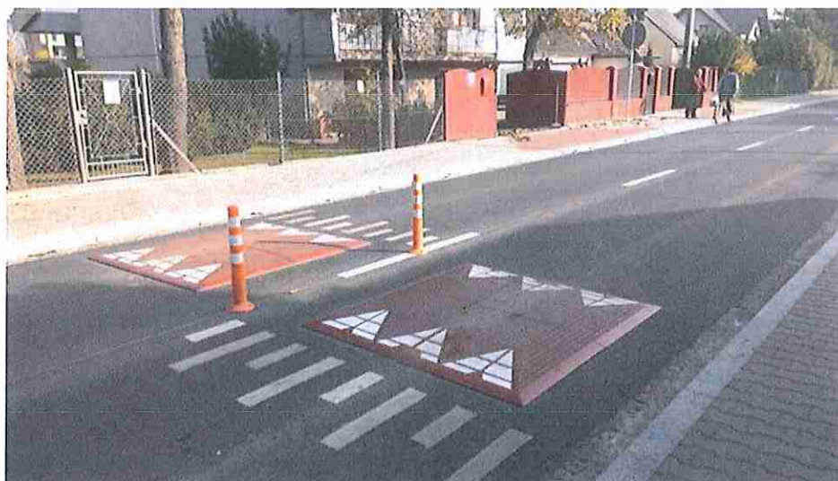
↑ Progi wyspowe (poduszkowe) przyjazne dla rowerzystów oraz komunikacji zbiorowej.
