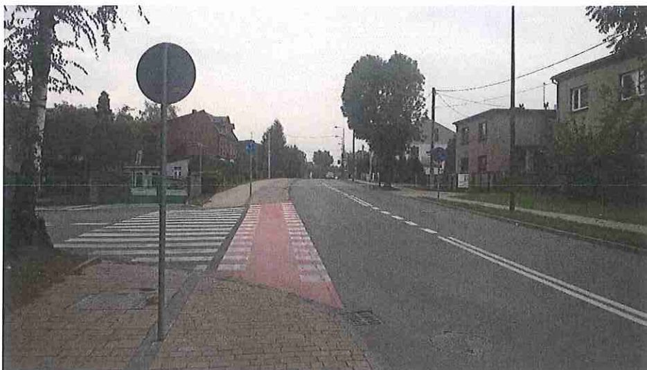
↑ Poprawnie poprowadzona droga dla rowerów w rejonie skrzyżowania, ul. Mikołowska.
