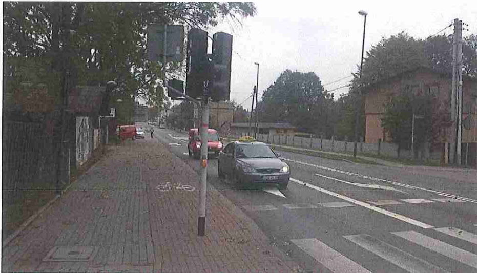
↑ Niebezpieczna lokalizacja słupa sygnalizacji świetlnej na środku drogi dla rowerów, ul. Dworcowa.
