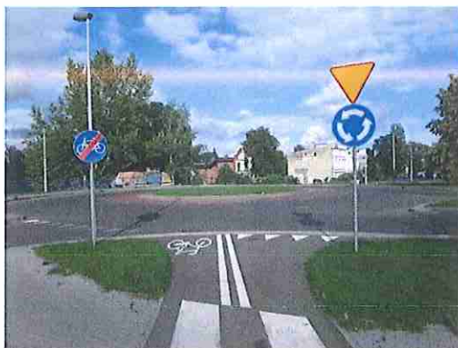
↑ Zdjęcie 4. Innowacyjne rozwiązania w zakresie infrastruktury rowerowej – droga dla rowerów jako samodzielny wlot skrzyżowania typu rondo.
