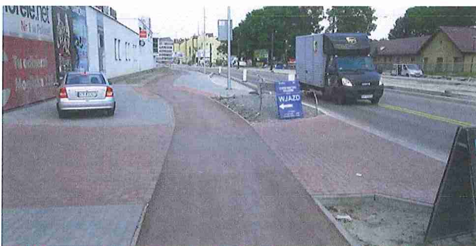
↑ Zachowana ciągłość niwelety nawierzchni drogi dla rowerów w rejonie zjazdu indywidualnego.
