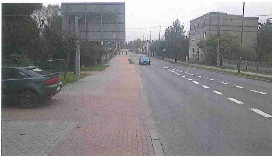
↑ Brak dostosowania niwelety zjazdu do niwelety drogi dla rowerów (ul. Dworcowa).
