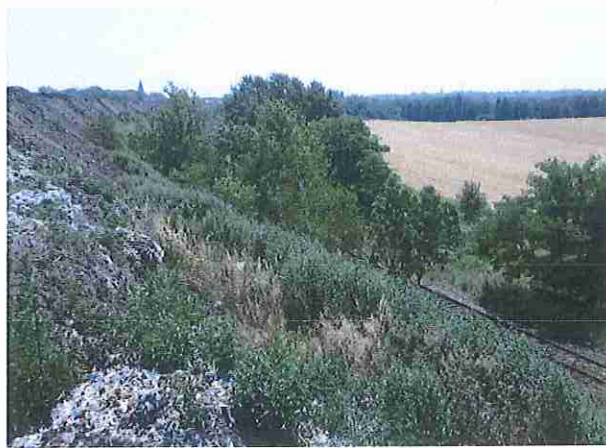
Fot. 6. Nieprawidłowe prowadzenie prac rekultywacyjnych na terenach przemysłowych
