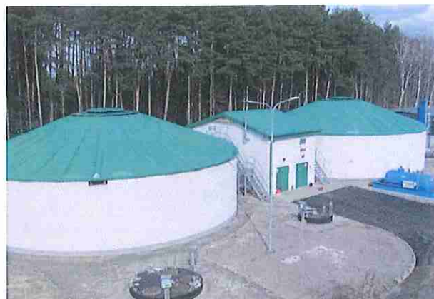
Fot. 5. OŚ „LEŚNA” - widok reaktorów biologicznych
