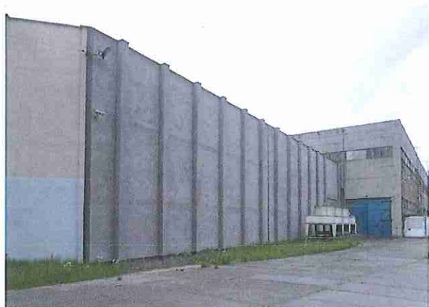
Fot. 4. Metalpol, Węgierska Górka - wybudowanie ekranu dźwiękochłonnego w postaci ściany murowanej, zapewniającego zastąpienie zespołu chłodni wentylatorowych
