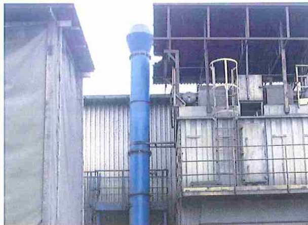
Fot. 5. Metalpol, Węgierska Górka - montaż obudowy dźwiękoizolacyjnej wentylowanej grawitacyjnie oraz montaż tłumika kanałowego na wylocie oczyszczarki
