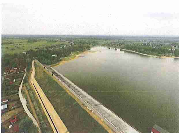
Fot. 7. Widok na zbiornik Przeczycze od strony korony zapory
