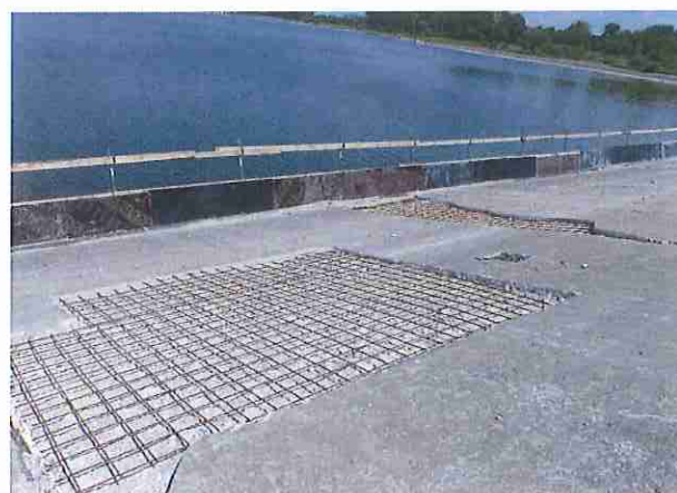
Fot. 9. Reprofilacja powierzchni betonowych
