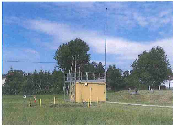
Fot. 5. Automatyka stacja pomiarowa jakości powietrza w Żywcu
