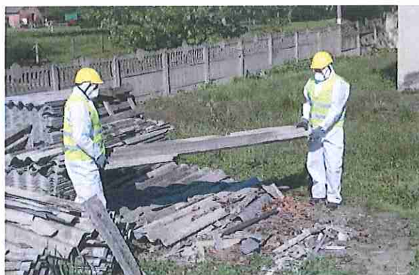
Fot. 10. Prace związane z usuwaniem azbestu
