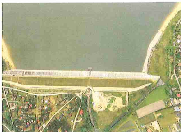
Fot. 8. Zapora zbiornika Przeczycze
